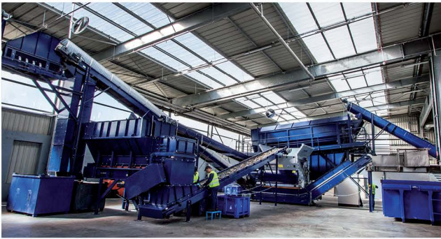
Unité de filtration et de valorisation
